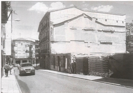
CALLE TEJUELA. Solar en el que se edificará el centro social polivalente de La Tejuela.
