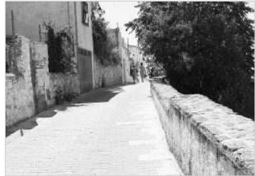
ASPECTO. Una de las calles del barrio de las Cruces que tendrán actuaciones urbanísticas. /S. C.
